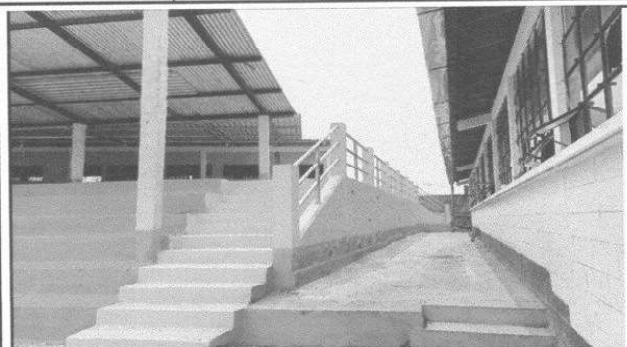
Foto 1: MURO PERIMETRAL GRADAS ACCESO FRONTAL
