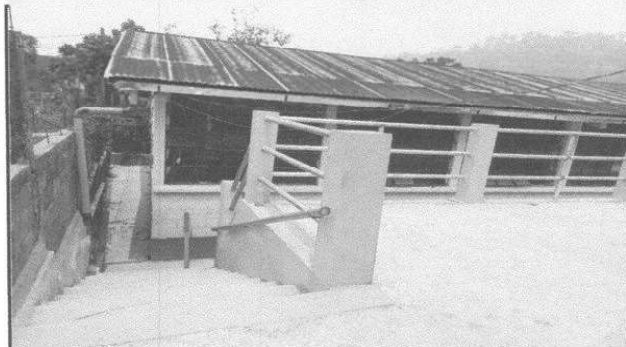
Foto 2: GRADAS ACCESO LATERAL DEL MURO PERIMETRAL
