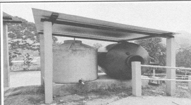
Foto 2: REPARACION DE TECHO DE LOS TINACOS
